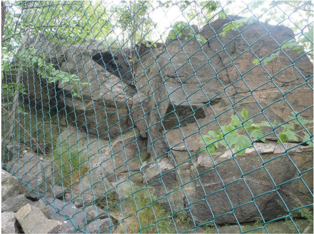
Foto 11. Alldeles utanför området, där Gårda 33:11 och 33:12 möts, ligger stora uppallade block. Dessa bedöms vara stabila. Bilden tagen mot öst.
