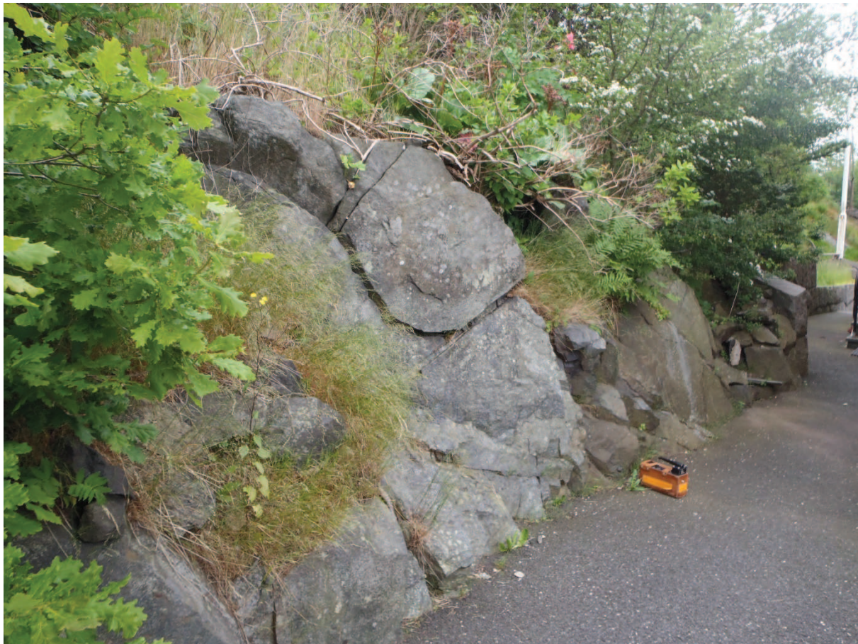
Foto 7. Ingången till Prospect Hillgatan 14. Berggunden är något blockuppsprucken. Bilden tagen mot syd.
