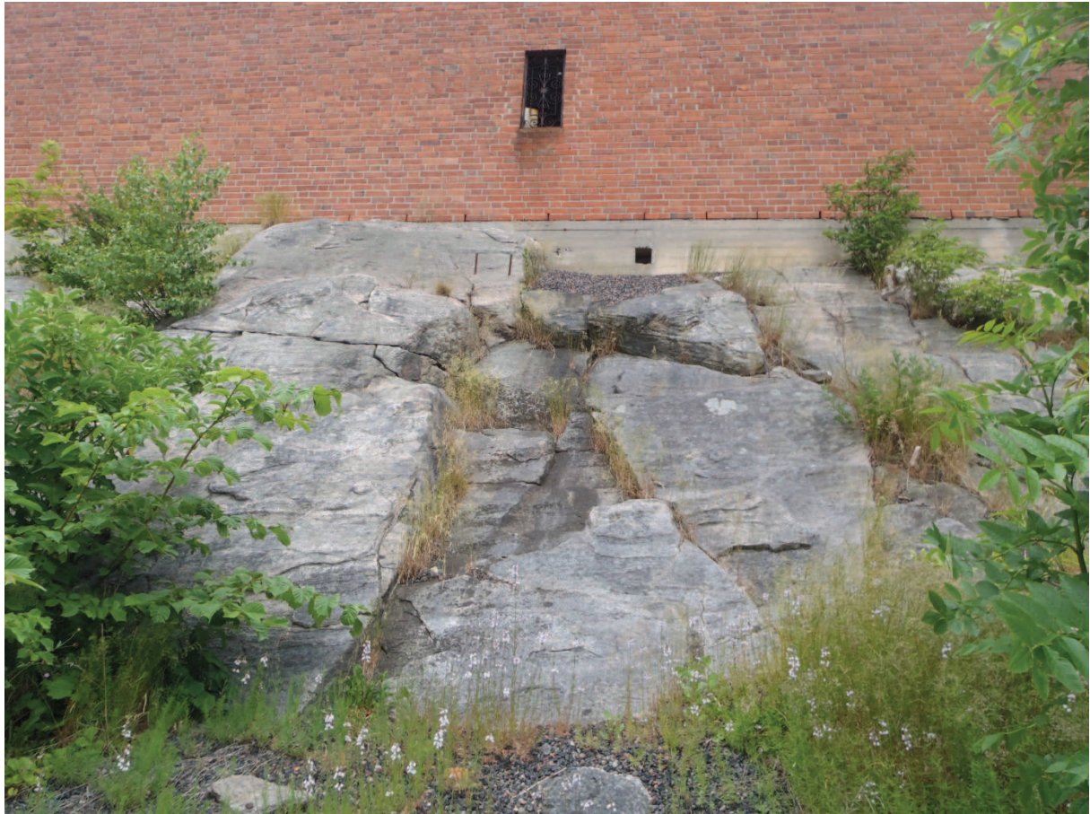
Foto 9. Bergslänten väster om huset Prospect Hillgatan 14 utgörs av gnejs och bildas av sprickor ur sprickgrupp 1 (hällytan) med sprickgrupp 2 och 4 tvärs slänten samt flacka sprickor. Bilden tagen mot öst.
