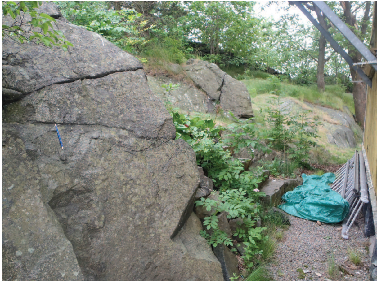
Foto 5. Bergskant bakom Prospect Hillgatan 12. Befintliga naturliga bergslänter bedöms idag vara stabila. Bilden tagen mot syd.
