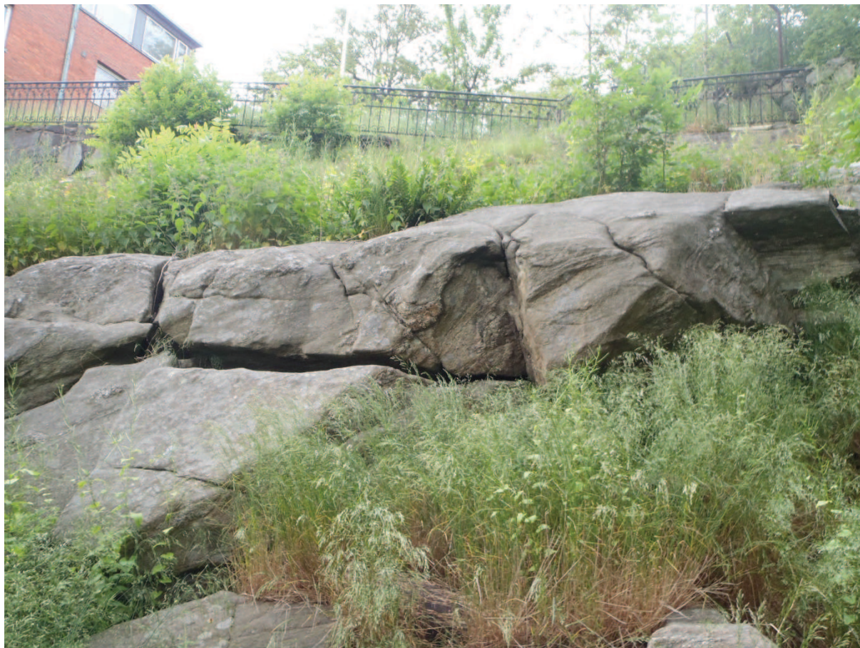
Foto 10. I den vegetationsbevuxna slänten väster om Prospect Hillgatan 14 finns framstickande kanter som är något mer blockuppspruckna. Kanterna är idag stabila. Bilden tagen mot öst.
